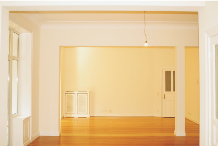
Abb. B.2.5: Der neue Wohnraum, gebildet durch den Ausbau einer Wohnungstrennwand. Jenseits der Wandöffnung das ehemalige Wohnzimmer der Wohnung 2.
