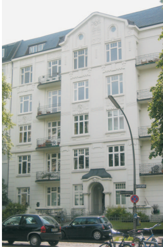
Abb. B.2.1: Ein Bau aus der Zeit des Jugendstils. Umgebaut wurde die Wohnung im Erdgeschoss links.
