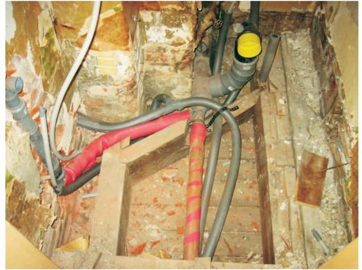
**Abb. D.14.9:** Es geht in solchen Fällen immer eng zu. Bevor Balken geschritten werden, sollten alle Alternativen geprüft werden. Diese Arbeiten dürfen nicht dem Installateur überlassen werden.
