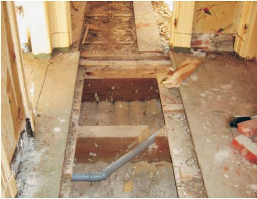
**Abb. D.14.8:** Ausschnitt eines Deckenbalkens für die Verlegung einer Abwasserleitung. Falls erforderlich sollte die Druckzone des Balkens wieder geschlossen werden. Soweit möglich sind hier Bohrungen vorzuziehen.
